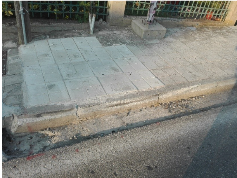
Σχήμα 7. Η σκηνή του ατυχήματος επί της Π.Ε.Ο. Κορίνθου – Πατρών (Χ.Θ. 101.700) στην είσοδο του οικισμού Καμάρες Αιγίου, το αρχικό σημείο πρόσκρουσης του αριστερού τροχού. Στο σημείο το ρεϊθρο του πεζοδρομίου έχει ύψος 0,25 μ., υψηλότερο του συνήθους 0,16 μ. και ο αύλαξ απορροής ομβρίων έχει υποβιβασθεί.
