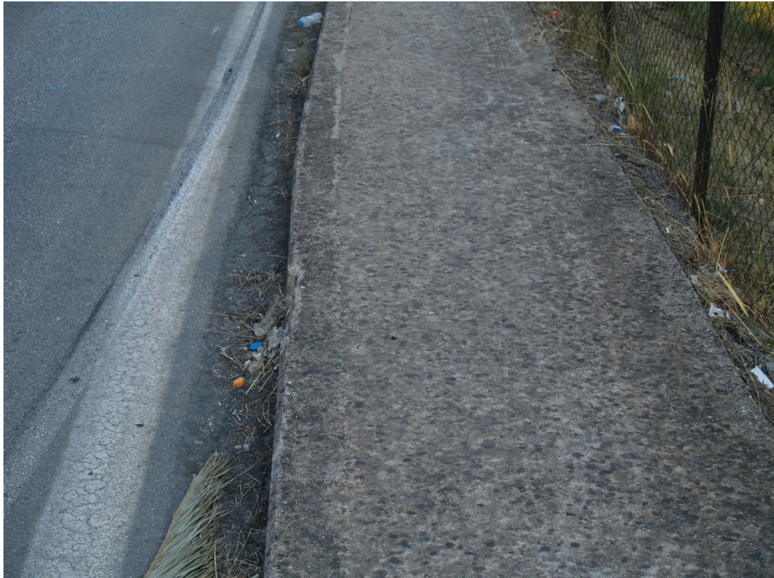
Σχήμα 18. Η σκηνή του ατυχήματος της 25ης Αυγούστου 2019 στη ΧΘ 101.700 στην Π.Ε.Ο. Κορίνθου – Πατρών, οι δεξιοί τροχοί του BMW M3 ανέρχονται στο πεζοδρόμιο στο ρεύμα κυκλοφορίας Πάτρα-Κόρινθος και εφαρμόζεται πέδηση στους οπίσθιους τροχούς.
