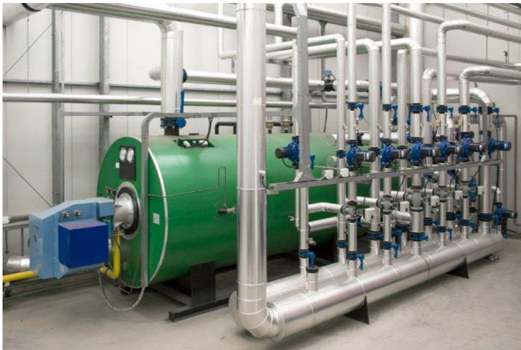
Εικόνα 2.3. Καυστήρας λέβητα κεντρικής θέρμανσης θερμοκηπίου με χρήση πετρελαίου ή και φυσικού αερίου ( http://haaringdebrabander.nl/ )
