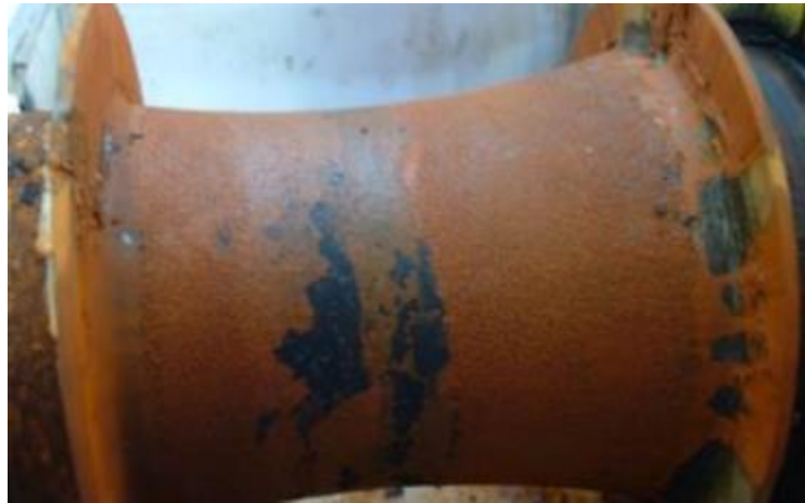
Σχήμα 1.13 Άξονας που έχει υποστεί διάβρωση με κόπωση.
