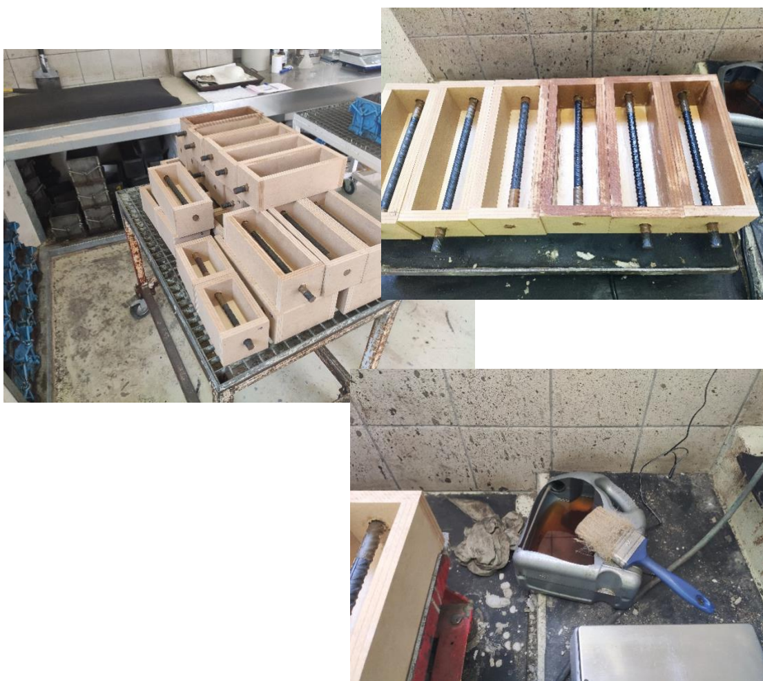
Εικόνα 3.2.3.(γ) : Διαδικασία τοποθέτησης ορυκτελαίου στον χαλύβδινο οπλισμό πριν την σκυροδέτησή του.
