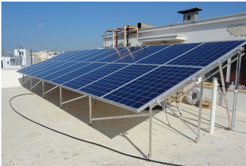
ΕΙΚΟΝΑ 4.1. ΤΟΠΟΘΕΤΗΣΗ Φ/Β ΣΥΛΛΕΚΤΩΝ ΣΕ ΒΑΣΗ ΜΕ ΣΤΑΘΕΡΗ ΚΛΙΣΗ
