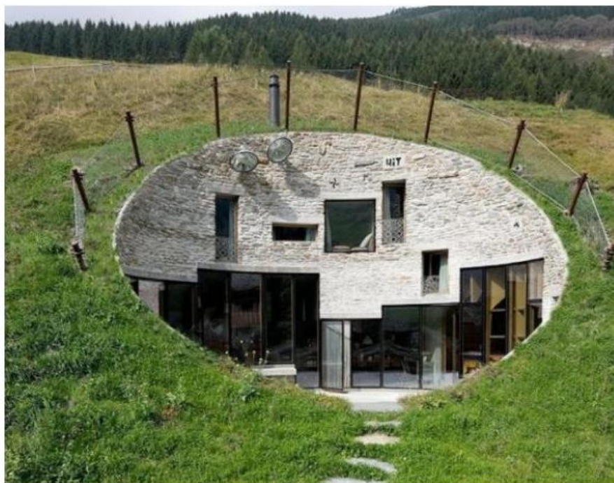
Εικόνα 9: Σύγχρονη υπόσκαφη κατοικία στην περιοχή Therme Vals (Ελβετία).[24]
