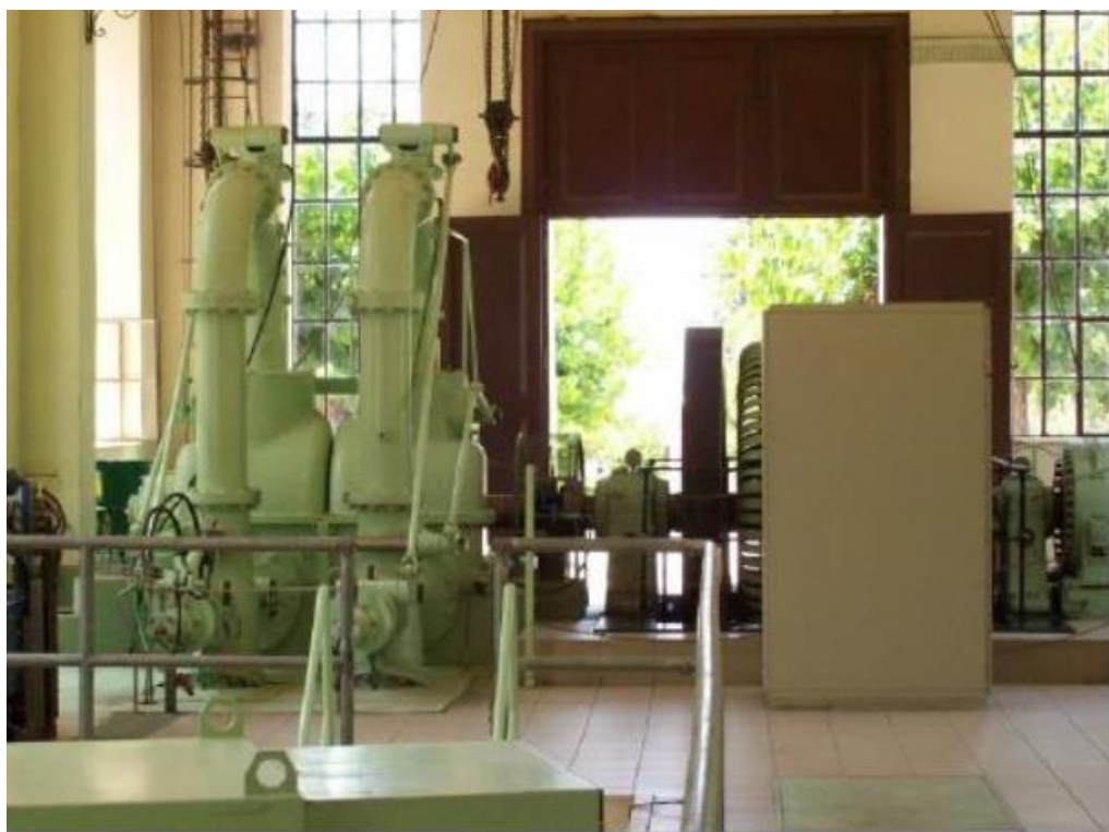
Εικόνα 23. Υδροστρόβιλος Pelton (Πηγή: Ευαγγελάτος, 2016)
