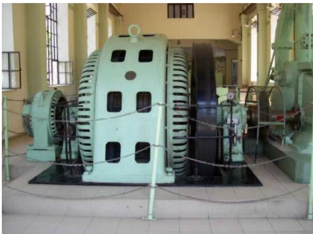
Εικόνα 24 .Γεννήτρια Pelton (Πηγή: Ευαγγελάτος, 2016)
