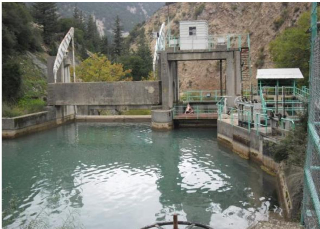
Εικόνα 10. Φράγμα ΜΥΗΣ Γλαύκου (Πηγή: Εναγγελάτος, 2016)
