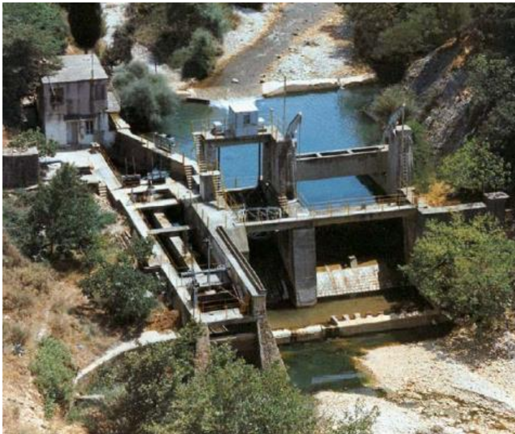
Εικόνα 12. Το σύστημα προσαγωγής. (Πηγή: Γεωργίτσας Α. & Σίννης Α., Μελέτης και Περιγραφή του ΜΥΗΣ Γλαύκου, Πτυχιακή Εργασία Τεχνολογικό Εκπαιδευτικό Ίδρυμα Πειραιά Σχολή Τεχνολογικών Εφαρμογών Τμήμα Πολιτικών Δομικών, ΔΕΗ Αναεώσιμες Α.Ε., 2010)
