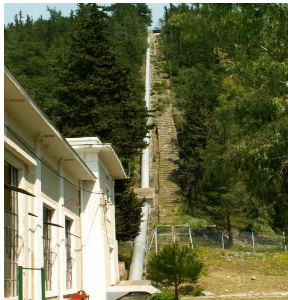
Εικόνα 18. Αγωγός Προσαγωγής. (Πηγή: Γεωργίτσας Α. & Σίννης Α., Μελέτης και Περιγραφή του ΜΥΗΣ Γλαύκου, Πτυχιακή Εργασία Τεχνολογικό Εκπαιδευτικό Ίδρυμα Πειραιά Σχολή Τεχνολογικών Εφαρμογών Τμήμα Πολιτικών Δομικών, ΔΕΗ Ανανεώσιμες Α.Ε., 2010).
