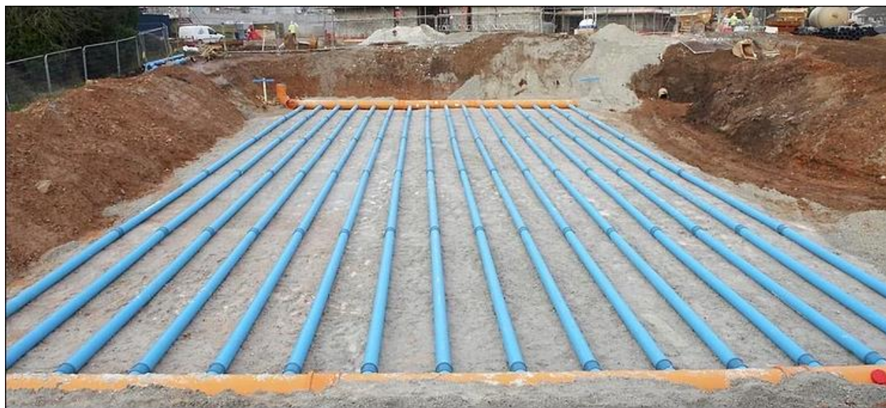
Εικόνα 1.2.1: Σωληνώσεις εναλλάκτη αέρα-εδάφους στη φάση της κατασκευής του εναλλάκτη. [30]
